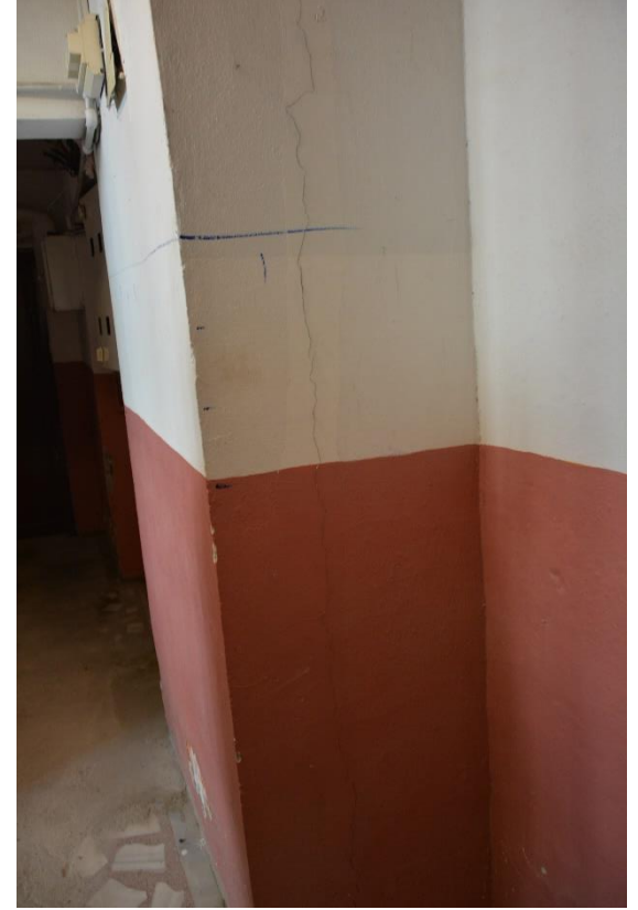
Duvar-kolon ayrılması
